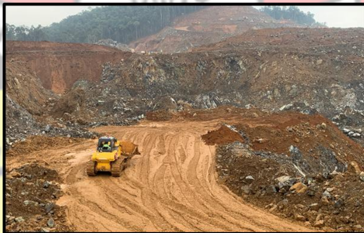
Gambar 1.11. Kegiatan Backfilling
