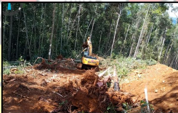
Gambar 1.7. Kegiatan pengupasan tanah pucuk
