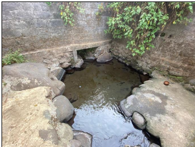
Gambar 6.9 Kondisi Eksiting Mata Air Besar, LP 1
