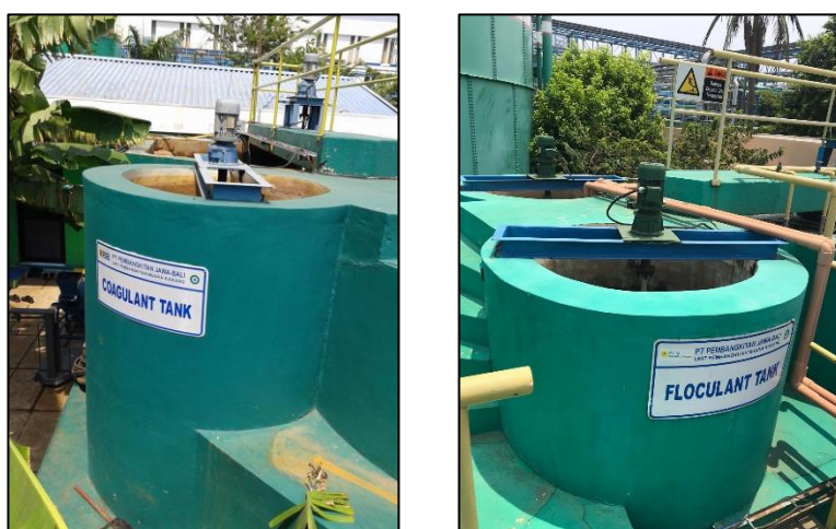
Gambar 2.6 Unit Koagulasi dan Flokulasi (Sumber: Analisis Penulis Tahun 2023)
