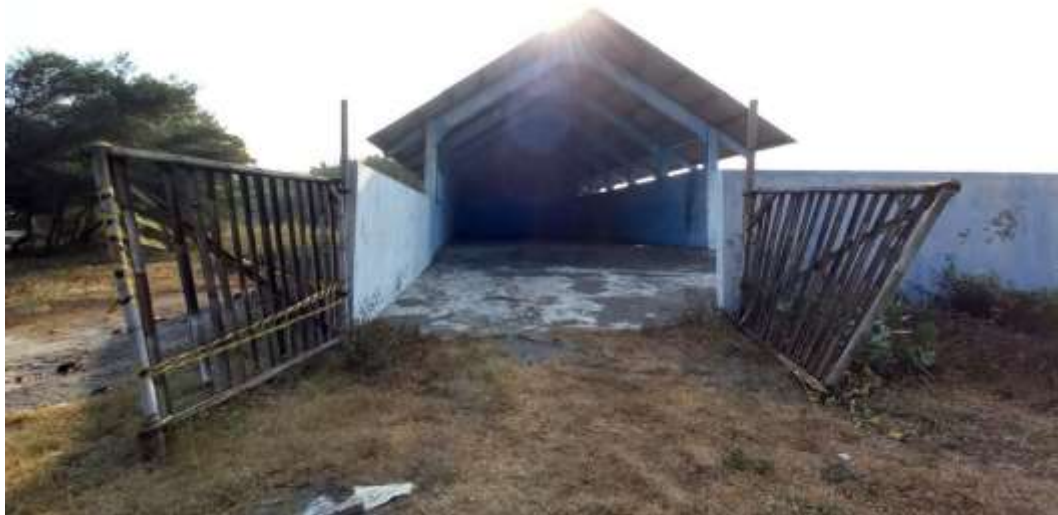
Gambar 8. Gedung Pengolahan Sampah
