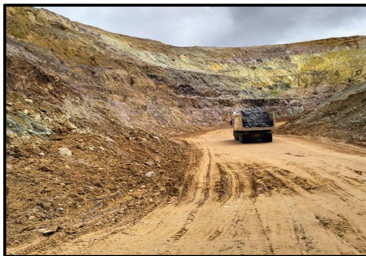
Gambar 4.3. Kondisi Jalan Angkut
