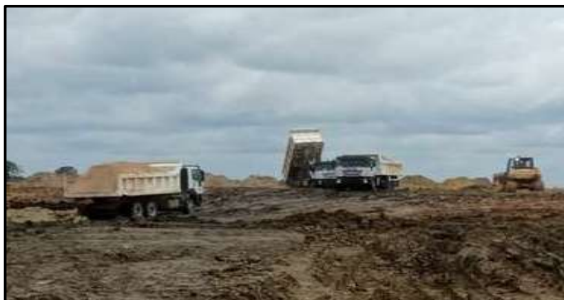
Gambar 2.10 Pengangkutan dan Penimbunan Tanah Penutup
