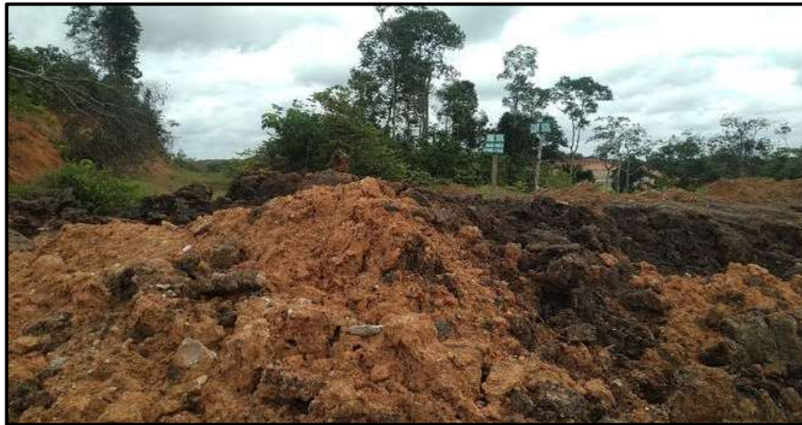
Gambar 2.8 Tempat Penyimpanan Tanah Humus ( Bank Top Soil )
