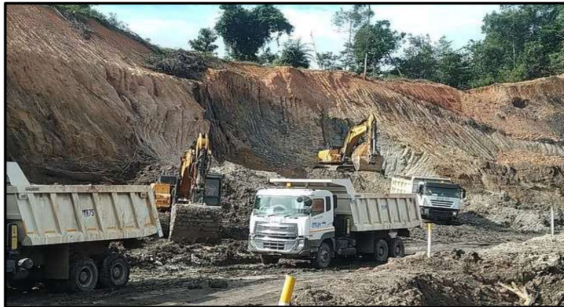
Gambar 2.9 Penggalian dan Pemuatan Tanah Penutup
