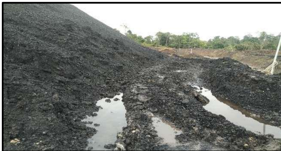
Gambar 4.10 Undulasi Pada Lantai Dasar Area Product Stockpile
