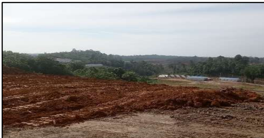
Gambar 2.15 Penyebaran dan Penataan Tanah Humus pada Tahapan Kegiatan Reklamasi
