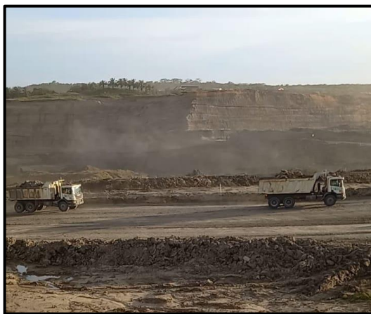
Gambar 2.7 Kegiatan Pengangkutan Overburden menuju Disposal dengan Alat Angkut
