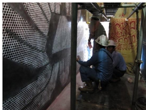
Gambar 2.26 Proses Pembersihan pada Tube Kondensor
