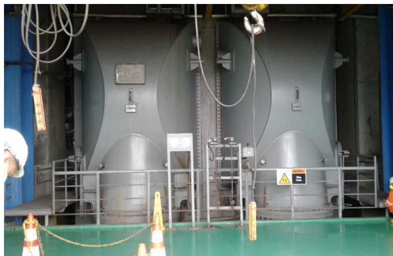
Gambar 3. Kondensor Unit 1
