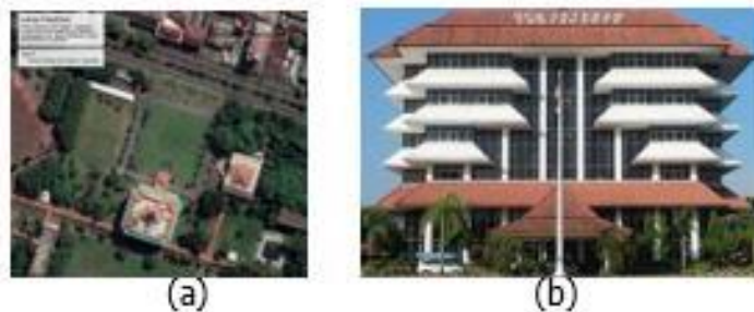
Gambar 2 Lokasi penelitian: Gedung Rektorat UPN “Veteran” Yogyakarta, (a)denah lokasi, (b) kenampakan fasad objek penelitian.
