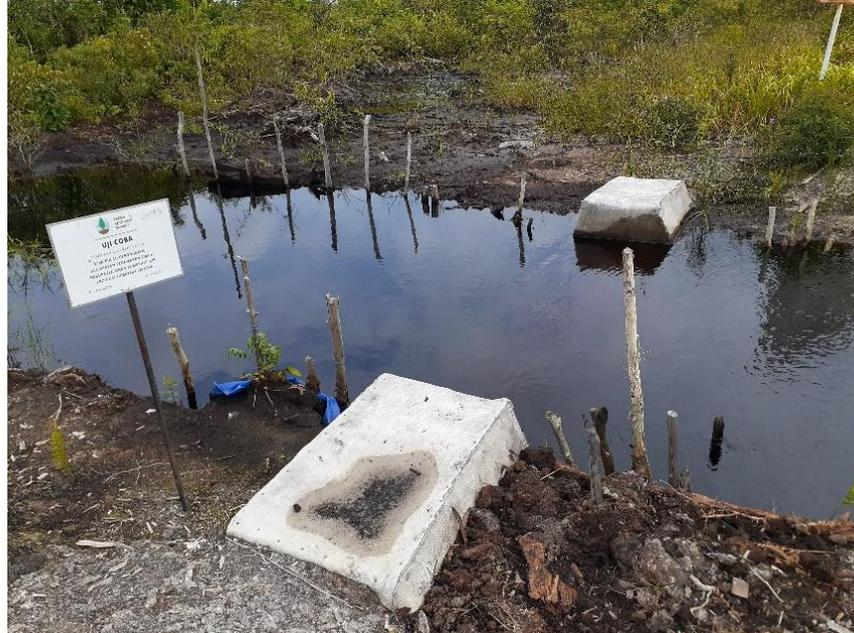
Gambar 5. 13 Talang air BRG metode kamps beton.
