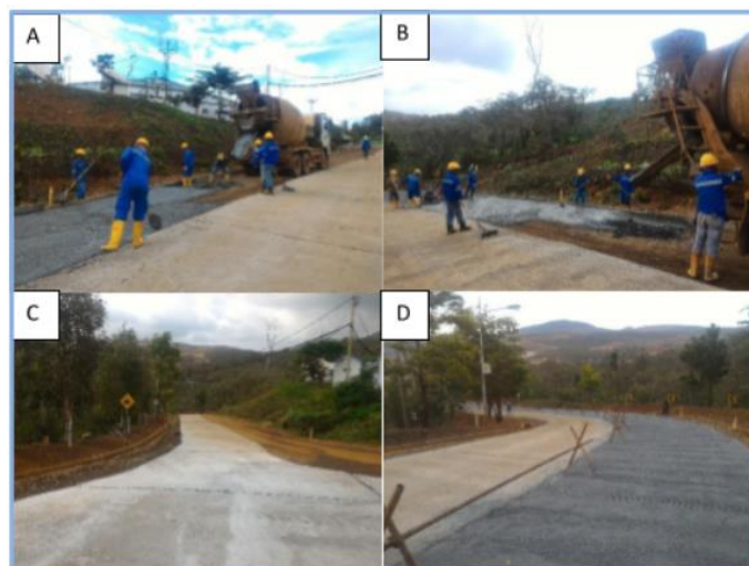
GAMBAR 2. Pembuatan jalan beton dengan pemanfaatan slag nickel +FABA
