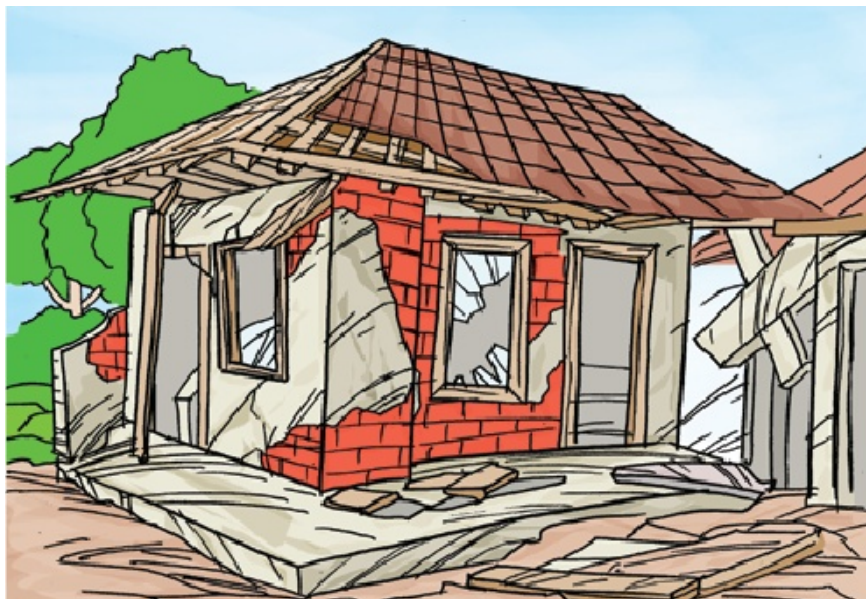
Gambar 3.4. Bangunan yang rusak akibat guncangan gempa ( Ground Motion )
