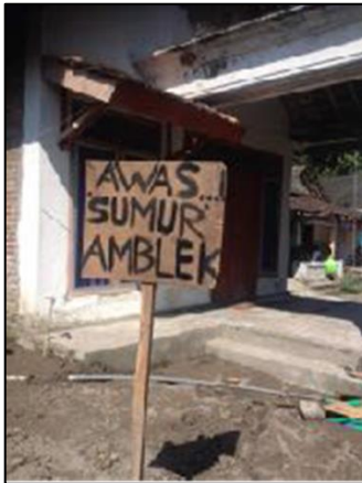
Gambar 4. Foto amblesan sumur di Desa Manggis, Kediri 2017
