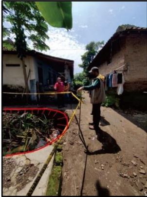
Gambar 2. Foto amblesan sumur di Desa Jungkare, Klaten 2021
