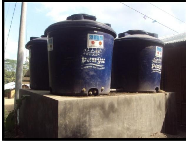
Gambar 5.1 Bak Penampung Air dari Mobil Tangki
