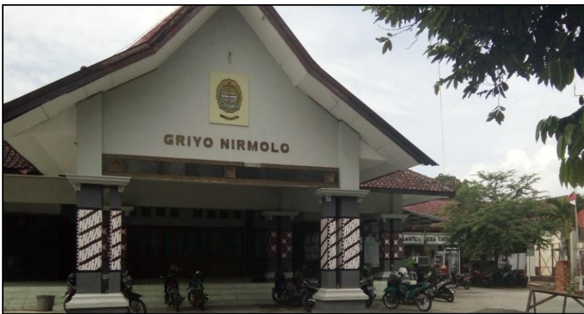
Gambar 1. Kantor Desa Tirtonirmolo, Kecamatan Kasihan, Kabupaten Bantul, Yogyakarta
