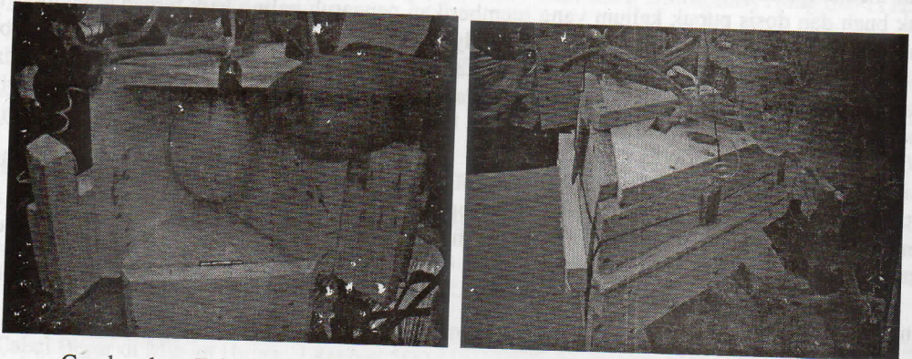
Gambar 1. a. Teknik pemasangan kotak kayu , b. Kotak kayu berbentuk segitiga
