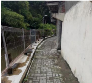
Kondisi awal titik penanaman di pinggir sungai
