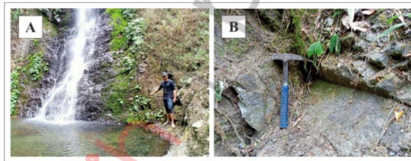
Gambar 5.26. Litologi pada Satuan Lava Manyutan 1 (LM1), A). Kenampakan satuan Lava Manyutan 1 pada LP W158 dengan azimut foto N020°E, B). Foto close up kenampakan singkapan W158 memperlihatkan struktur sheeting joint .
