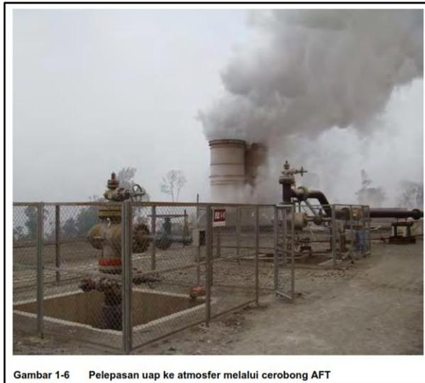
Gambar 1-6 Pelepasan uap ke atmosfer melalui cerobong AFT
