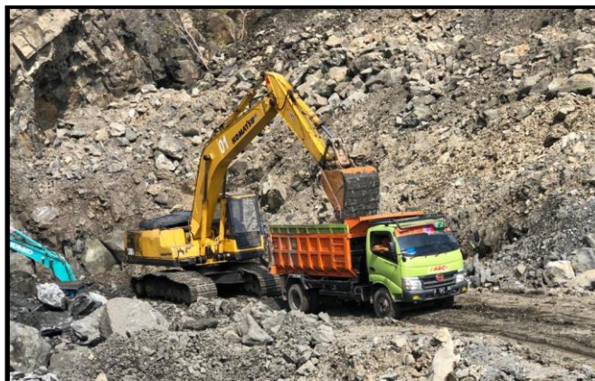
Gambar 2. 6 Pemuatan Dengan Backhoe merek Komatsu Tipe PC 200
