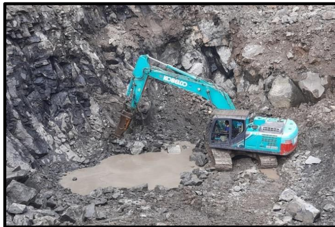
Gambar 2. 5 Pembongkaran Dengan Rock Breaker merek Kobelco Tipe SK 200
