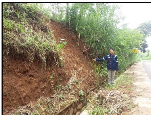
**Gambar 4.15 Kenampakan Gerakan Massa Tanah di Daerah Penelitian, pada LP 27**
