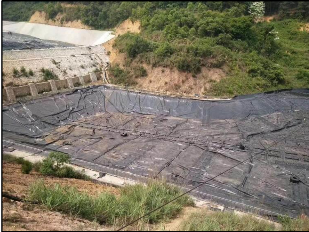
Gambar 5.19. Pemasangan geomembrane pada area tepi sungai.
