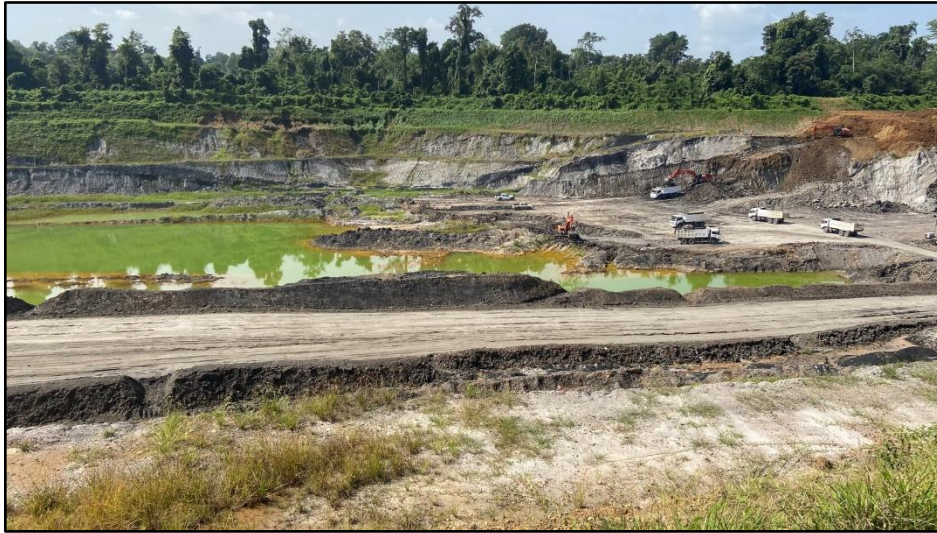
Gambar 6.3. Air asam penambangan batubara terbuka berpotensi menimbulkan perubahan pH air pada lokasi pengamatan 86, arah kamera selatan.
