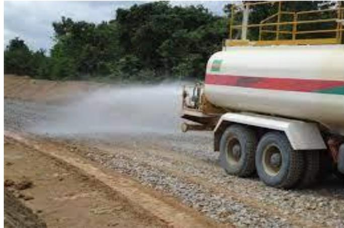
**Gambar 2.12. Proses Penyiraman Air Menggunakan Water Truck**
