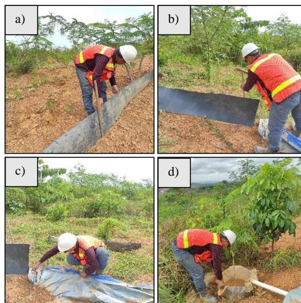
**Gambar 3.11. a) Memasang Geomembran Sebagai Penahan Dinding Erosi; b) Memasang Patok Sebagai Penahan Geomembran; c) Memasang Terpal; d) Pemasangan Pipa yang Terhubung ke Drum Sebagai Penampung Aliran LP 13**
