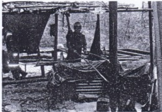
Gambar 3.7. Pengurasan sumur minyak dengan timba
