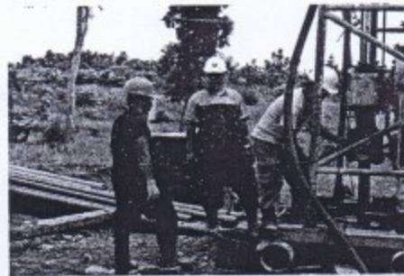
Gambar 3.18. Pekerjaan Re-opening sumur tua dengan spindle
