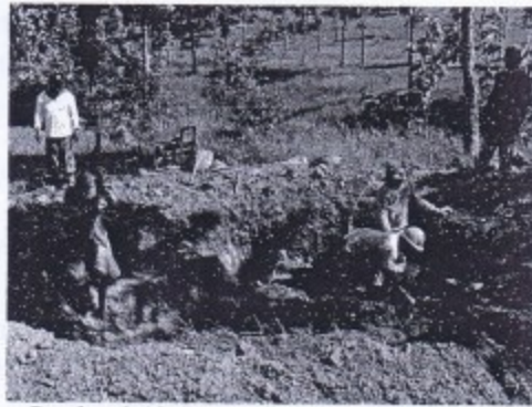
Gambar 3.13. Penggalian Lokasi Sumur Tua
