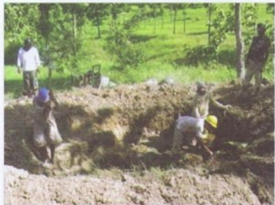
Gambar 2.22. Penggalian Lokasi Sumur Tua
