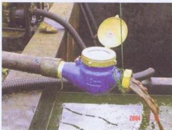
Gambar 2.35. Contoh Out let Pompa ESP/175 untuk produksi sumur tua
