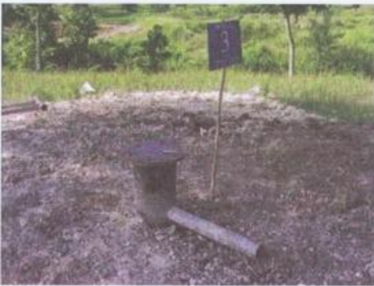
Gambar 2.24. Kepala Sumur Tua Siap untuk di Re-opening
