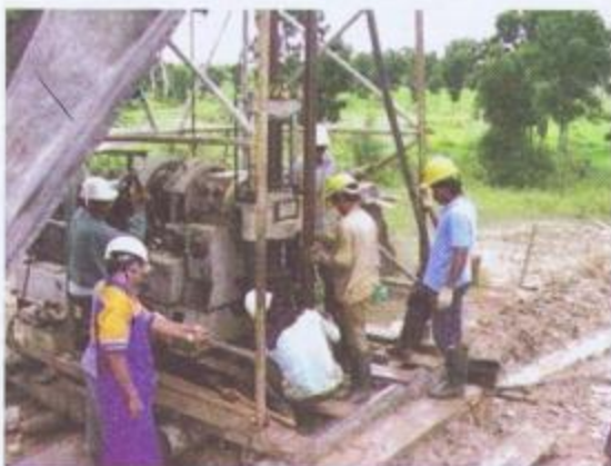
Gambar 2.25. Pekerjaan Re-opening Sumur Tua Dengan Spindle
