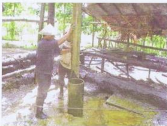
Gambar 2.16. Tombros yang digunakan untuk pembersihan sumur tua
