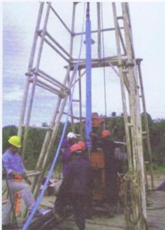
Gambar 2.36. Contoh Pemasangan Pompa ESP/175
