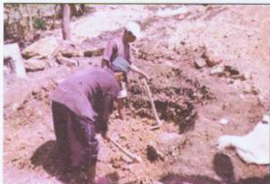
Gambar 2.13. Kegiatan Persiapan Pembukaan Lokasi Sumur Tua
