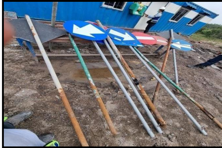
Gambar 4.4 Pemasangan dan Perawatan Rambu
