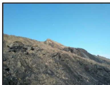
Gambar 5.5 Lereng Low wall pada under C
