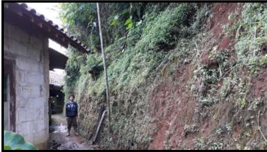
Gambar 6.11. Kenampakan lereng 4 yang berpotensi longsor pada lokasi pengamatan 127. Lereng berada di Desa Clapar dengan tinggi 4,5 meter, lebar 20,3 meter, panjang sisi miring 4,9 meter dan kemiringan lereng 65^{\circ} . Azimuth N 170^{\circ} E.
