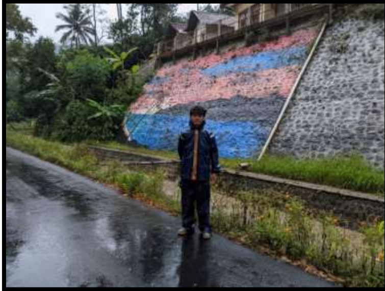
Gambar 6.13. Solusi Mengurangi Dampak Gerakan Massa dengan pembuatan grouting semen di lereng desa Limbangan
