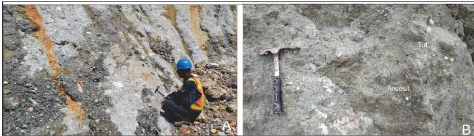
Gambar 4. A. Foto singkapan breksi vulkanik teralterasi silika + kaolinit ± dickit ± alunit pada LP 81 (azimuth foto N277°E) B. Foto litologi breksi vulkanik (azimuth foto N245°E)
