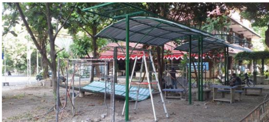
Gambar 2.10 Pemasangan kerangka gazebo di depan Gedung Dekanat Fakultas Teknologi Mineral.
