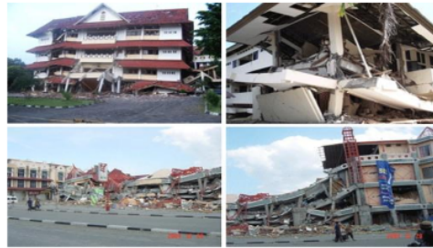
Gambar 1. Dampak Gempa Terhadap Bangunan
