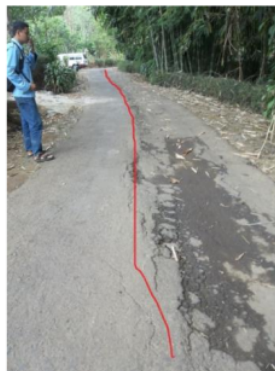
Gambar 17. Retakan di sepanjang jalan
