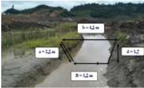
Gambar 3.1. Kondisi Aktual Saluran Terbuka I
