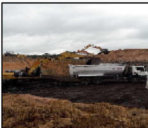
Gambar 6 Pola Pemuatan Top Loading Dikombinasikan dengan Single Back up
