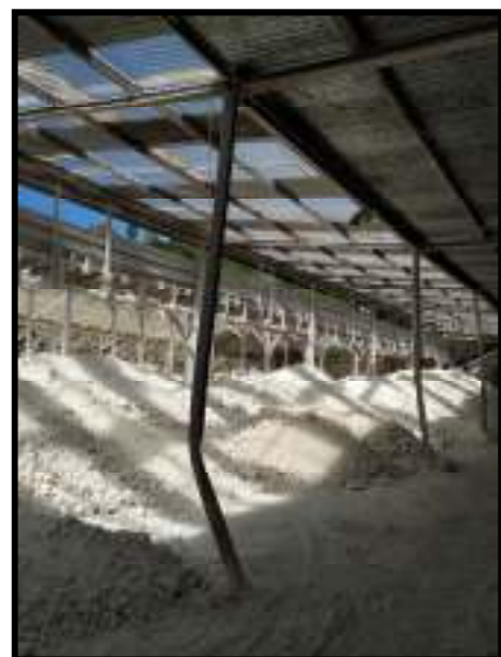
Gambar 5. Penyangga Atap yang Sudah Melengkung
