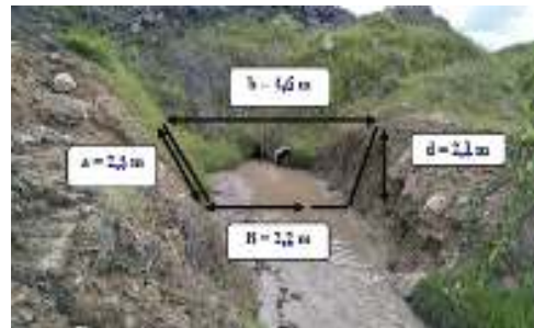
Gambar 3.5. Kondisi Aktual Saluran Terbuka V
