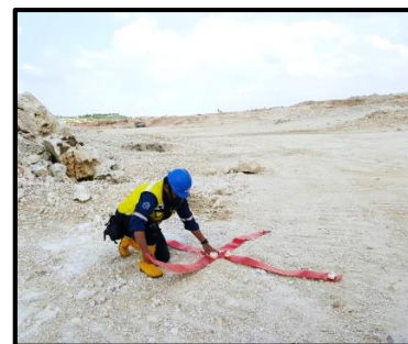
Gambar 3 Pemasangan Premark
