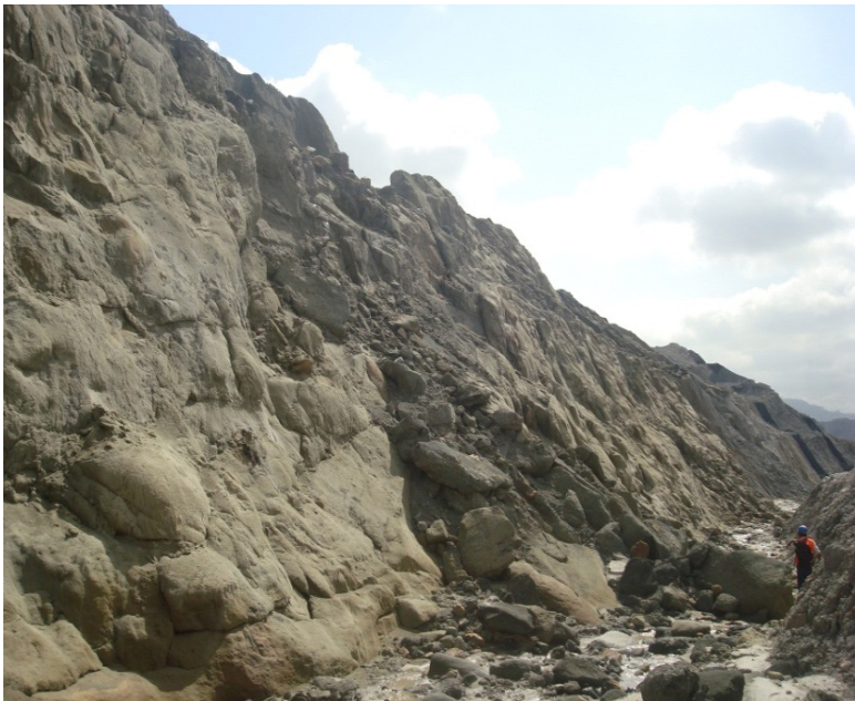
Gambar 38. Kelongsoran lereng tunggal di Lowwall Pit PAMA
