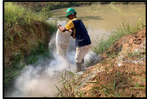
Gambar D.16 Pengkapuran di KPL
