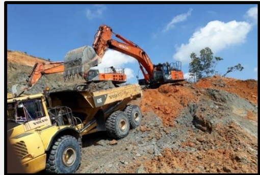
Gambar D.2 Pengupasan Tanah Pucuk
