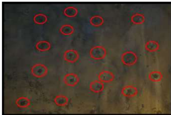
Gambar 4. Pola pemasangan threadbar
