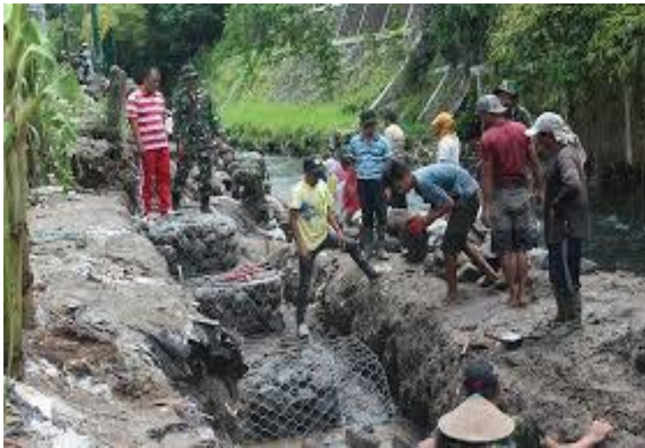
Gambar 4.2. Bangun talud di sekitar sungai Gajah Wong
