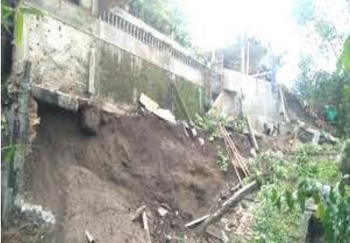
Gambar 9.1. Bangunan di sekitar sungai membayakan keselamatan penghuninya dan merusak lingkungan
