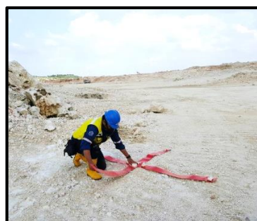
Gambar 3 Pemasangan Premark
