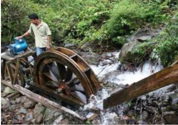
Gambar 1.8. Pembangkit listrik tenaga mikrohidro (<http://keuanganlsm.com/pembangkit-listrik-tenaga-mikro-hidro-tingkatkan-ekonomi-masyarakat/>)
