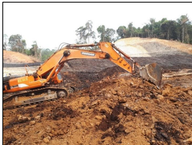
Gambar 2.6 Kegiatan Pengupasan Tanah pucuk
