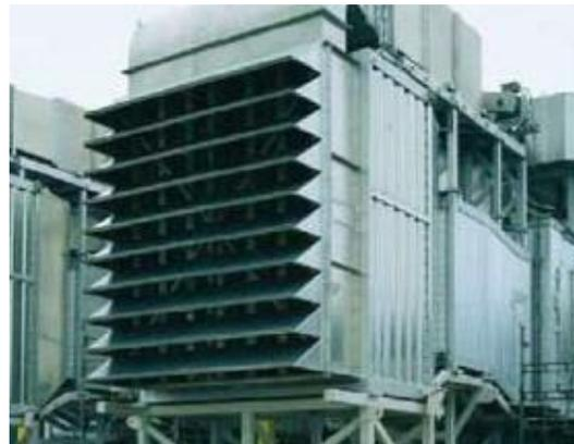
**Gambar 34. Weather hood pada sistem filtrasi**
