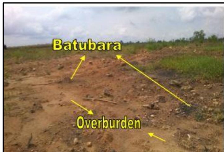
Gambar 4.6 Penataan Tanah Bagian Atas Pada Lahan Bekas Tambang
