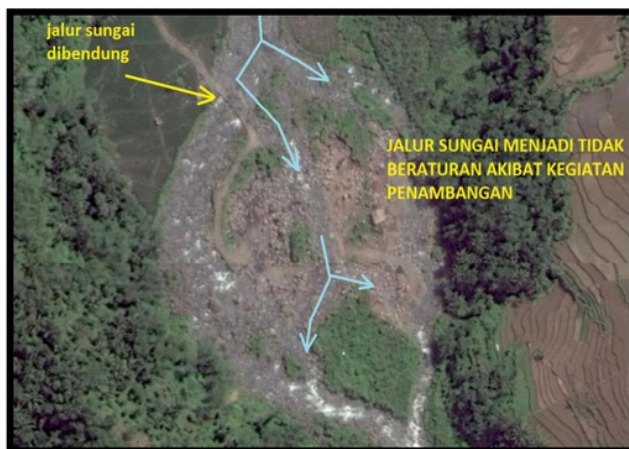
Gambar 6. Aliran Sungai yang Tidak Beraturan Diakibatkan Terhalang Oleh Jalan Tambang Pada Lokasi Penambangan I di Desa Baseh, Kecamatan Kedungbanteng
