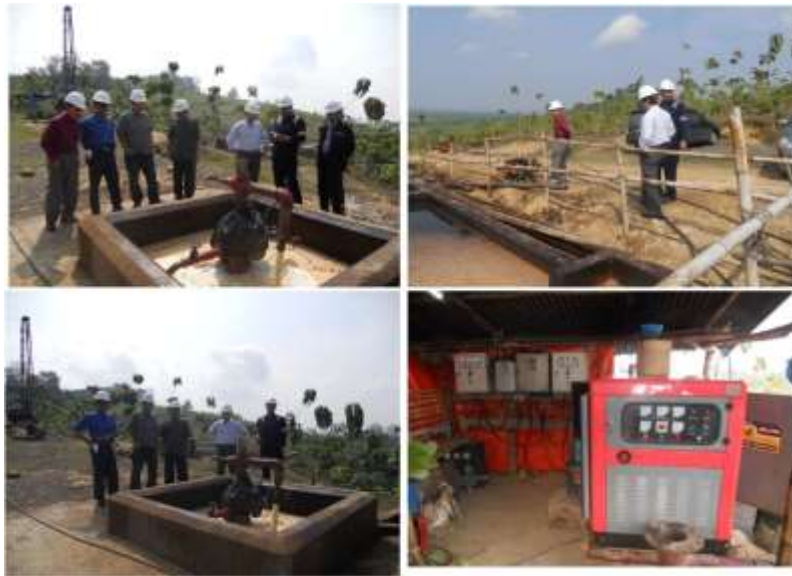
Gambar 4. Pompa APTG untuk produksi sumur tua di Lapangan Kendinding Cepu
