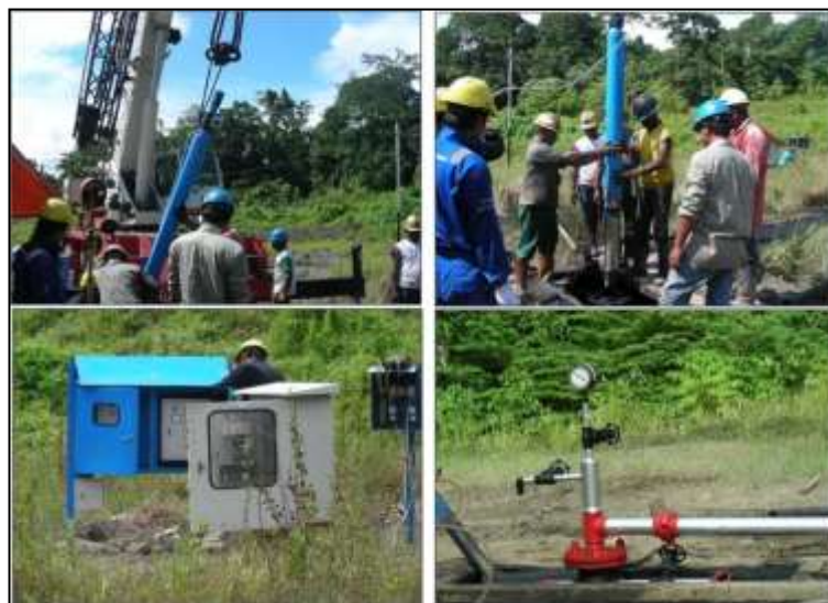
Gambar 3. Pompa APTG untuk produksi sumur tua di Lapangan Klamono, Sorong
