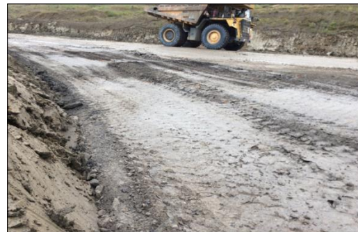
Gambar 4.2 Kondisi Jalan Angkut
