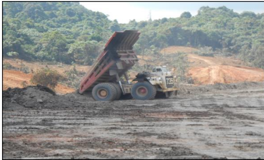
Gambar 4.3 Kondisi Area Penimbunan
