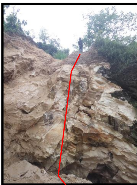
Gambar 4.6 Foto Pengukuran Tinggi Dinding Galian menggunakan Meteran, tepatnya di Poligon 1, Titik Pengukuran ke 6.
