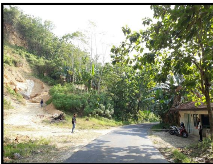
Gambar 4.4 Foto Pengukuran Jarak Tepi Galian (kepemilikan lahan) dengan Infrastruktur (Rumah) menggunakan Meteran, tepatnya di Poligon1, Titik Pengukuran ke 5.
