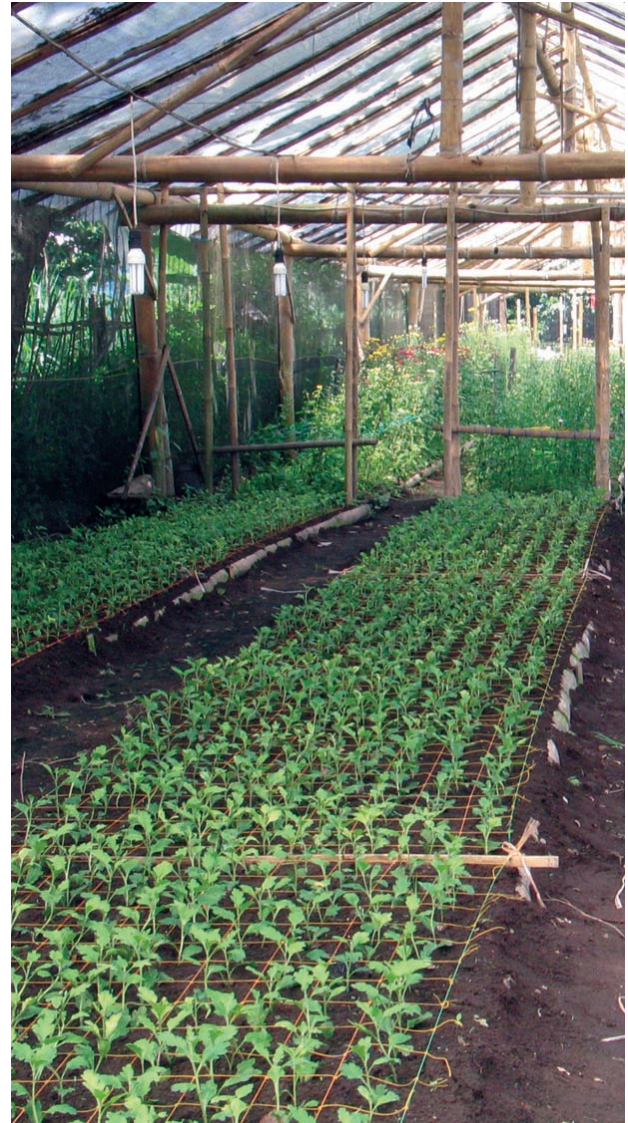
Rumah naungan dengan konstruksi bambu.
