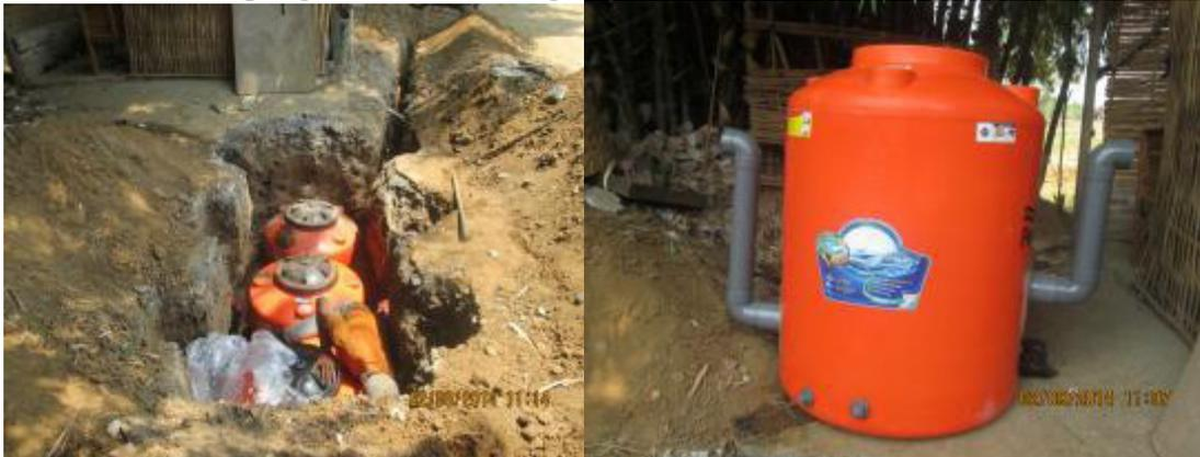
b. Saluran keluar residu Saluran ini digunakan untuk mengeluarkan kotoran yang telah difermentasi oleh bakteri. Saluran ini bekerja berdasarkan prinsip kesetimbangan tekanan hidrostatik. Residu yang keluar pertama kali merupakan *slurry* masukan yang pertama setelah waktu retensi tertentu ( 20 – 30 hari ).
