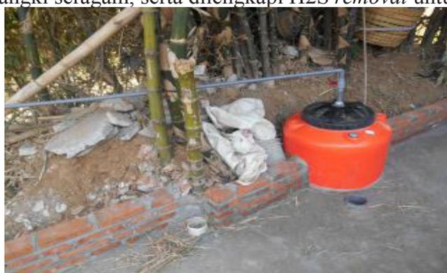
3. Proses fermentasi an-aerobik. Pada digester terjadi proses fermentasi an-aerob. Proses fermentasi anaerobik untuk menghasilkan biogas berlangsung selama 8-10 hari. Dan dalam proses fermentasi an-aerobik ini terjadi dalam 3 tahap secara berantai, yaitu:
