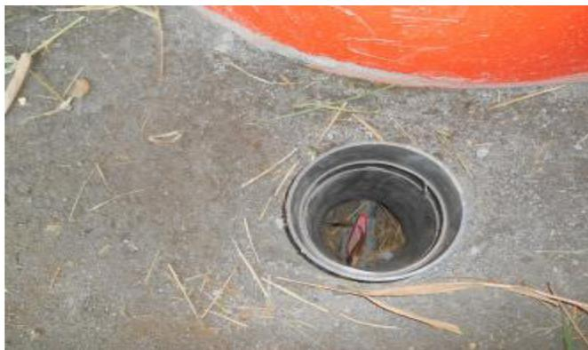
d. Saluran Gas Saluran gas ini disarankan terbuat dari bahan polimer atau plastik seperti pipa paralon untuk menghindari korosi. Ujung saluran pipa bisa disambung dengan pipa baja anti karat untuk bagian pembakaran gas.
